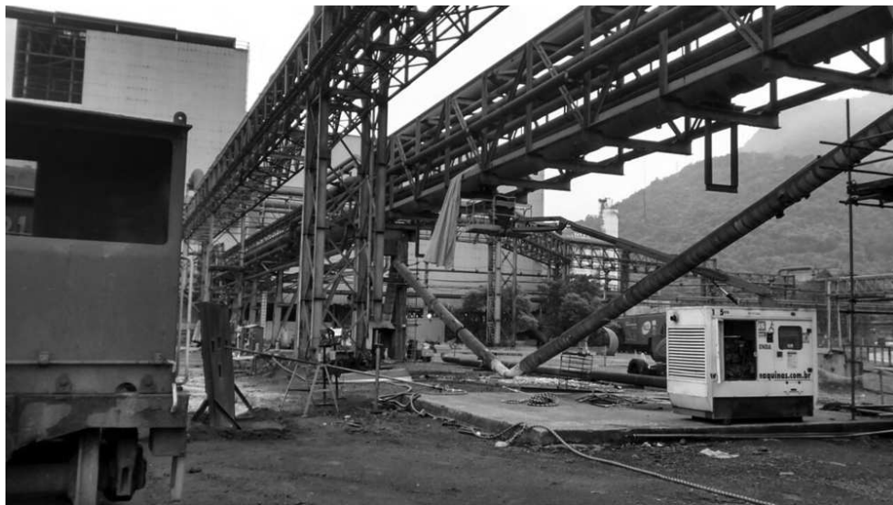
SUCATÃO - Para ilustrar a gravidade do que falamos, veja a situação da tubulação de vapor na usina
