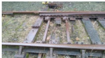
Os desvios P- 61, 62, 69, 73, 75 e 77 estão abandonados pela gerência de transportes, dormentes podres, parafusos de fixação dos trilhos, sensores de acionamento sinal sonoro soltos, são riscos espalhados pela área . Esse ano já ocorreu descarrilamento de vagões.
