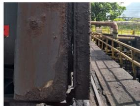
**Mais problemas:** Os trabalhadores além de serem obrigados a acumular funções são obrigados a ir para a área com equipamentos em péssimas condições como atender a limpeza dos poços contaminando toda a área operacional por falta de borracha de vedação e saturadas nas tampas dos caminhões.
